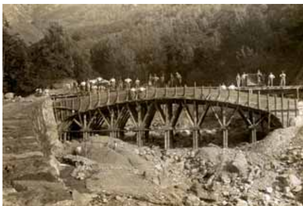
Stazzona, fine anni '20 - Ponte sul torrente Rivalone - Impresa Ninatti & Comp.
